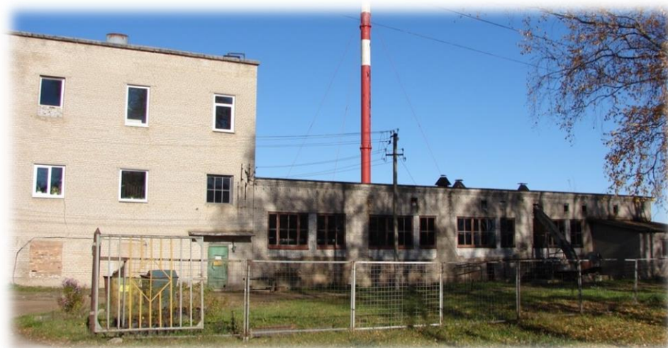
Рисунок 3. Котельная дер. Старополье.
