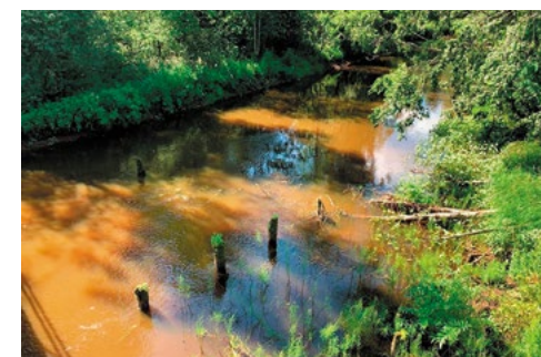
Рис. 6.6. Руинированные гидротехнические сооружения. Старые опоры моста, корчи в русле. р. Вьюн
