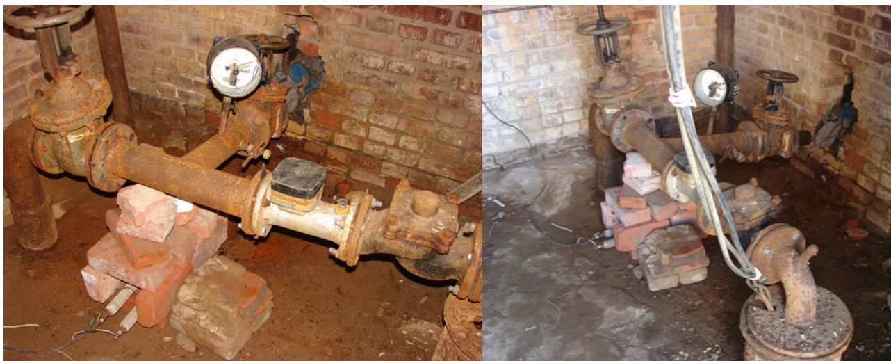
Рисунок 7 – Состояние оборудования в здании скважины (Овсище)
