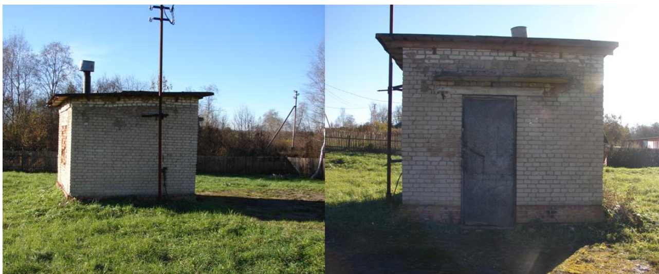
Рисунок 6 – Здание скважины в деревне Овсище
