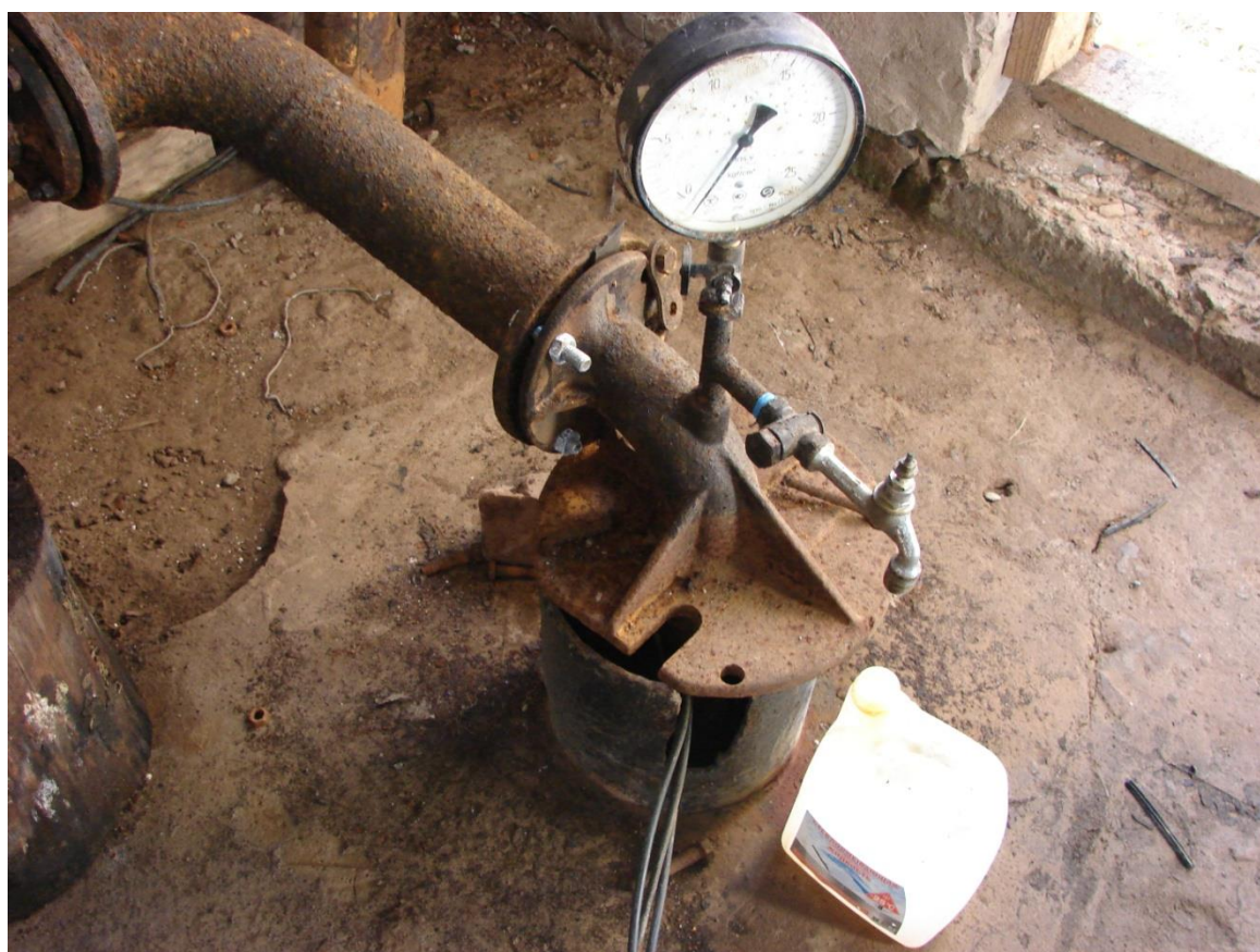
Рисунок 4 – Оборудование в здании скважины
