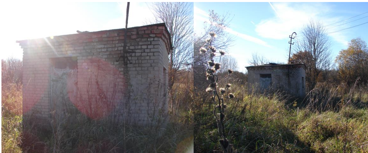
Рисунок 9 – Здание скважины в деревне Кологриво
