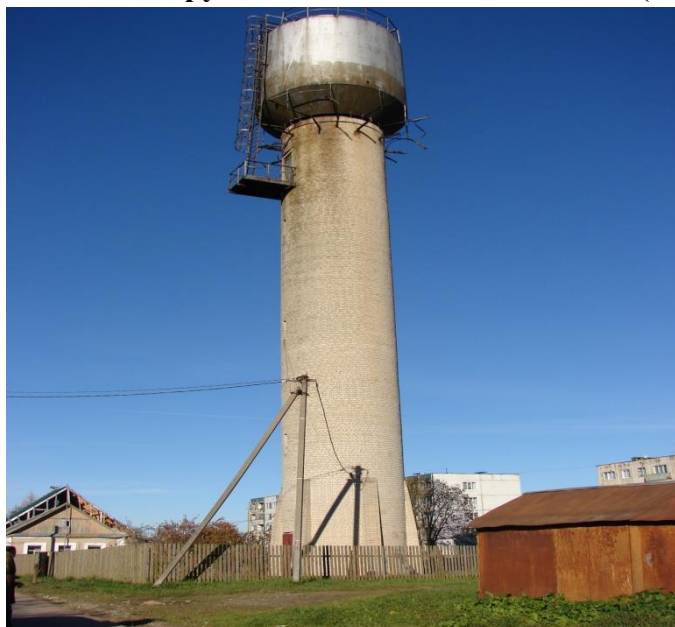
Рисунок 8 – Водонапорная башня (Овсище)
