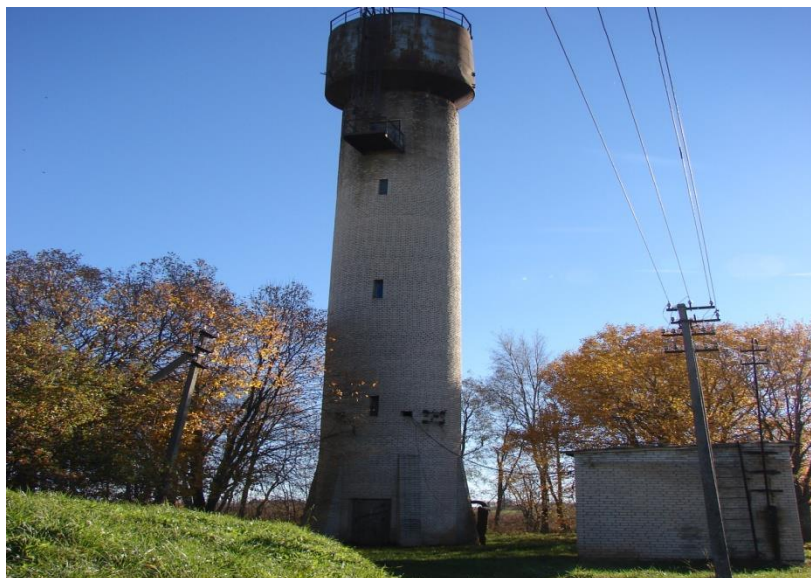
Рисунок 5 – Водонапорная башня (Старополье)
