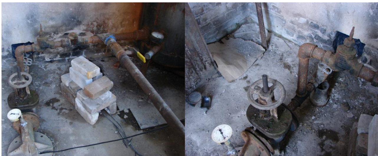
Рисунок 10 – Оборудование внутри здания скважины (Кологриво)
