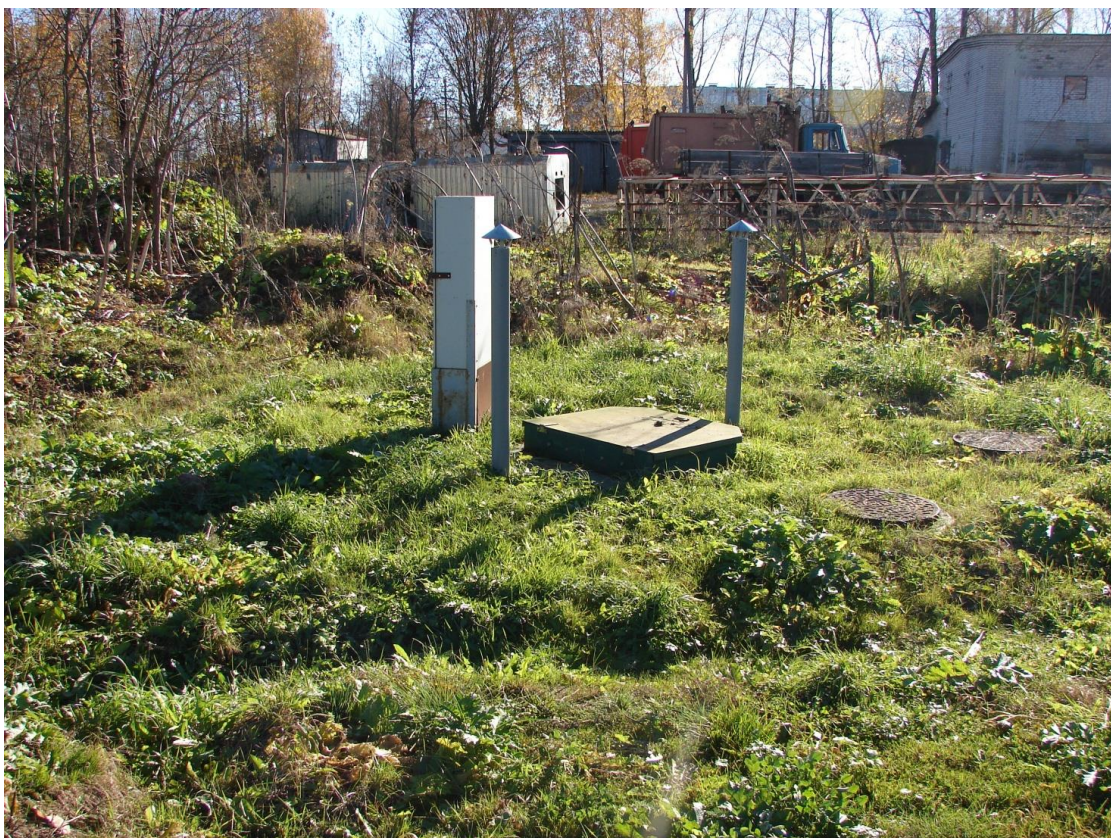
Рисунок 27 – Канализационная насосная станция (Старополье)
