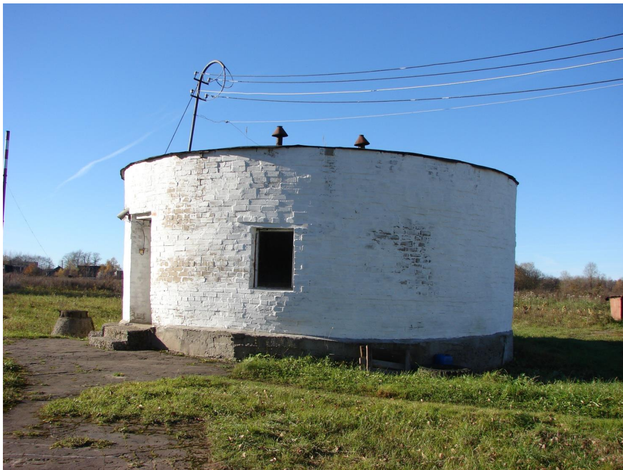
Рисунок 28 – Канализационная насосная станция (Овсище)
