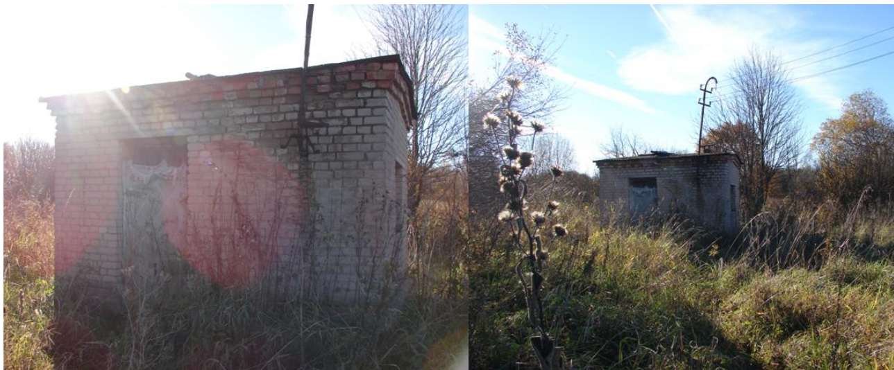
Рисунок 7. Здание скважины в деревне Колодриво
