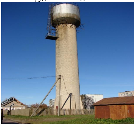
Рисунок 6. Водонапорная башня (Овсище)
