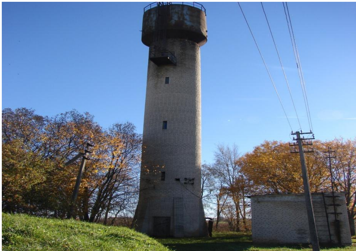
Рисунок 3. Водонапорная башня (Старополье)
